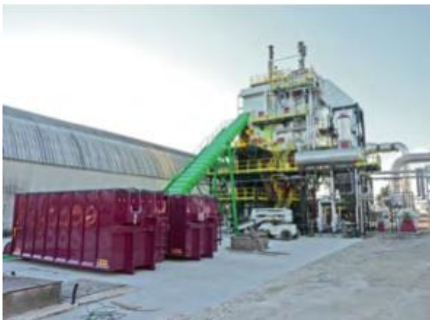
Figure 39 : Chaudière biomasse d'Azur distillation (Source : Bois international, les cahiers du bois énergie, n°69).
